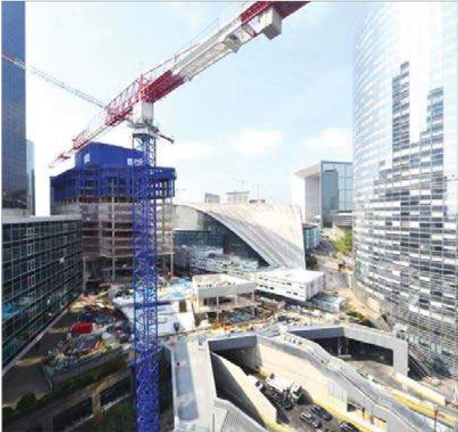
トリニティ・タワー — 中間階における異なる床レベルの調整
