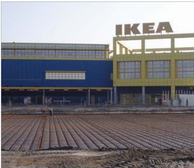
駐車場下の雨水散水タンク
