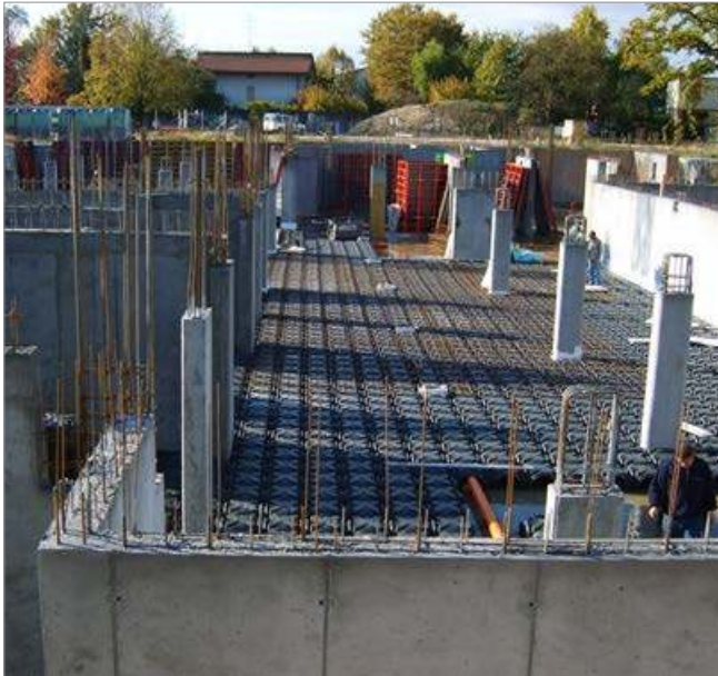
住宅用換気床下空洞
