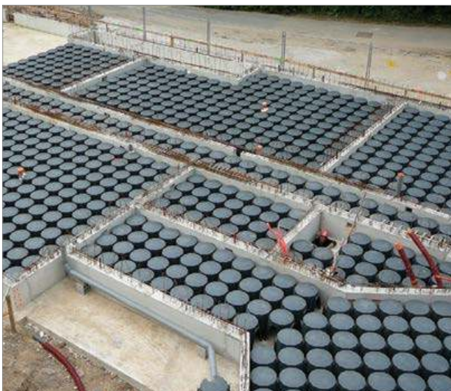
住宅用換気床下空洞
