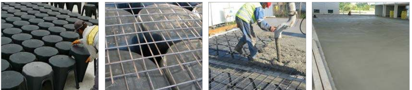
IGLÜ® の配置、続く補強、コンクリート打設および平滑化の一連の作業の詳細ビュー
