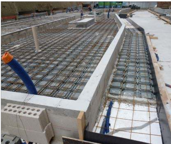
スロープおよび隙間の作成
