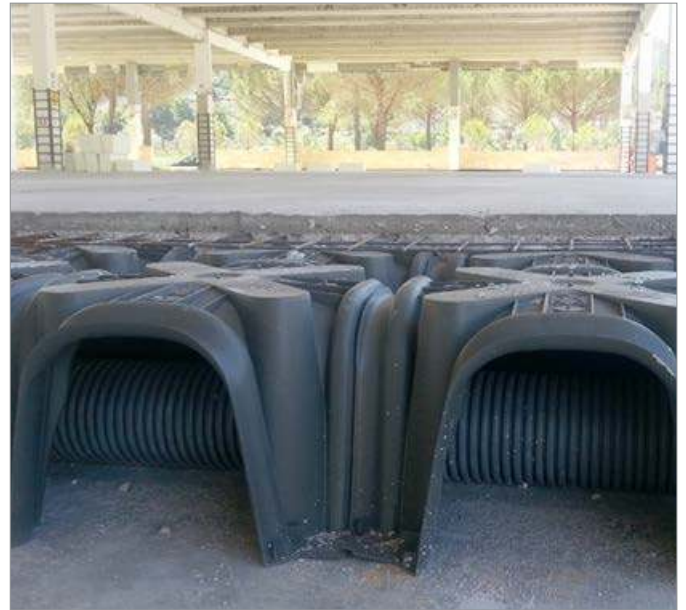
設備配管の通過例
