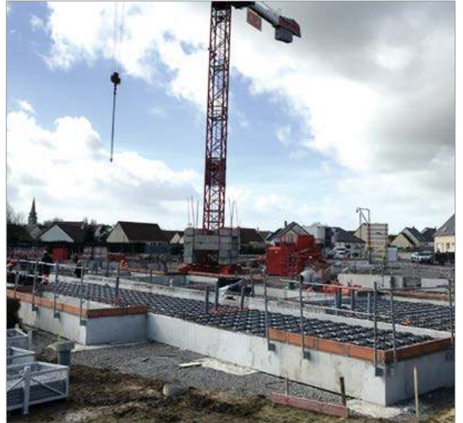
住宅建築における換気型床下空間
